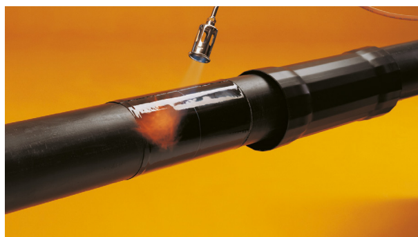
Erhitzen der Schrumpffolie. Erste Dichtstufe
